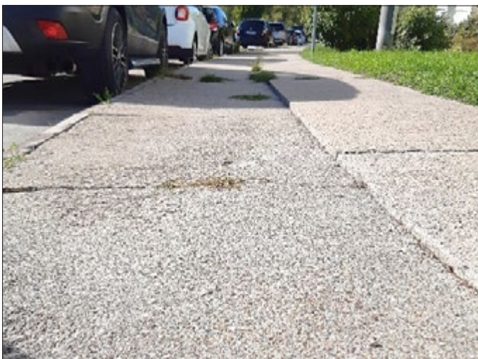
während der Reparaturarbeiten
