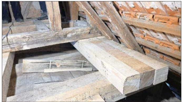
Mittels moderner Hebeteknik konnte der Turm angehoben werden, um neue Balken einzuziehen. Foto: F. Lang
