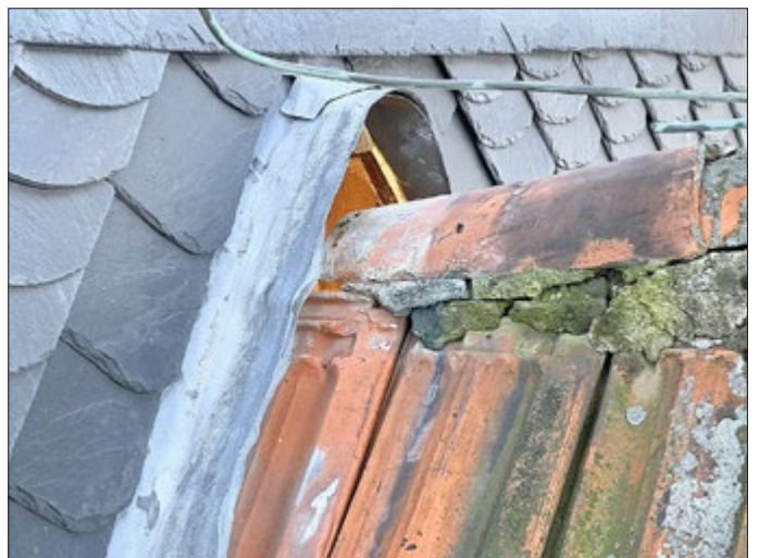
Zwischen Turm und Dach öffnete sich beim Hebevorgang ein deutlicher Lichtspalt. Foto: F. Lang
