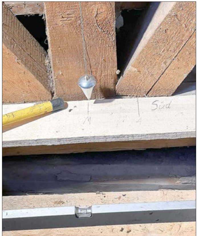
Mit Schnur und Lot wurde der Bewegungsradius beim Ausrichten des Turmes gemessen. Foto: F. Lang
