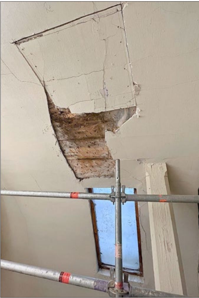
Die herausgeschnittene Deckenplatte wurde wieder eingesetzt. Unter dem abgefallenen Deckenputz kamen historische Bemalungen des Tonnengewölbes zum Vorschein. Foto: F. Lang
