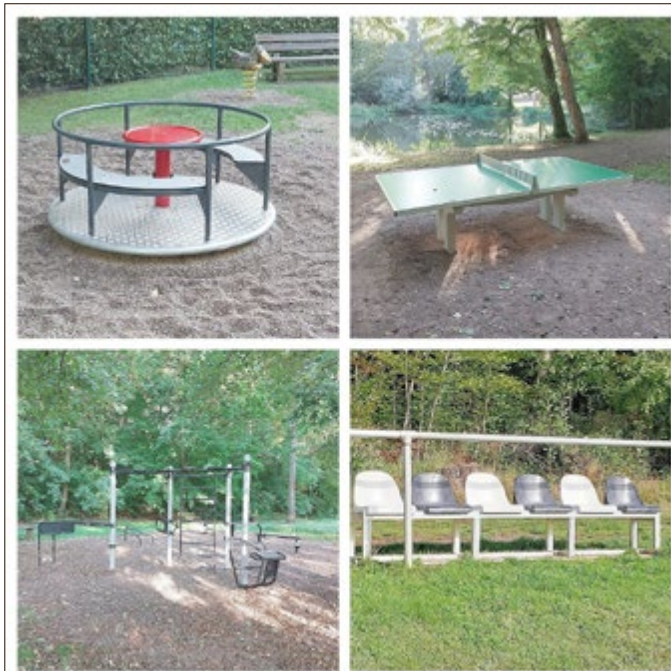
Baumaßnahmen Schlosspark Farnroda und Sportplatz Mosbach
