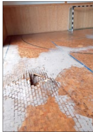
Triftberghalle alt vor der Sanierung
