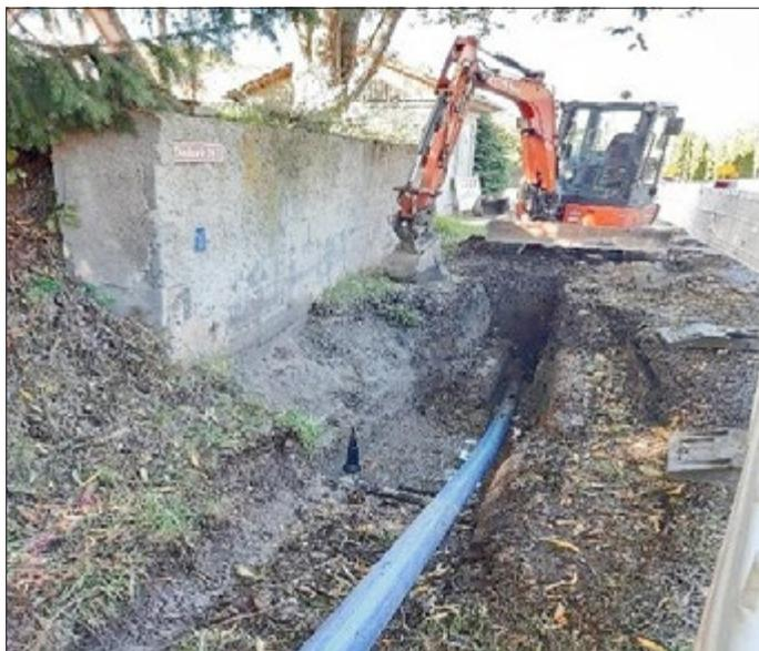
Bauabschnitt der Trinkwasserleitungsverlegung in Deubach durch den TAV EE Hier wurde auf einer Strecke von ca. 310 m die Trinkwasserleitung erneuert.
