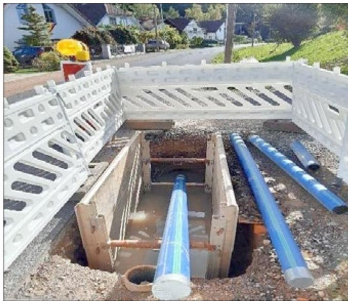
Es wurden neun Hausanschlüsse und im Bereich der Hausnummern 27j-27b der Trinkwasserringschluss hergestellt.
