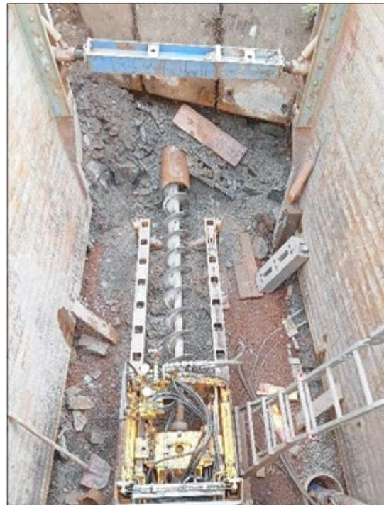
Nach Abschluss der Bachquerungsarbeiten in der 21.KW wurde mit den Arbeiten am Hauptkanal begonnen. Hier wurden bereits bis zum Ende der 28. KW von erforderlichen ca. 600,00 m die ersten ca. 150,00 m geschafft.
