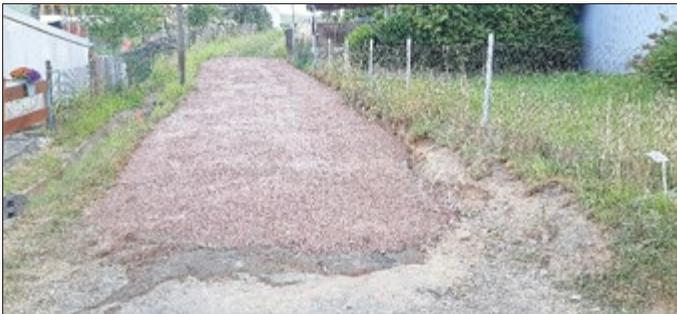
Um die Anwohner auf der linken Seite in Richtung Dorfmitte (hinter den Mosbach) an die Versorgungsleitungen anschließen zu können, wurde pro Anschlussstelle unter dem Mosbach im Bohrverfahren eine Bachquerung hergestellt. In diese 21 Bohrungen wurden Leerrohre für Wasser, Strom, Breitband und Abwasser eingezogen.
